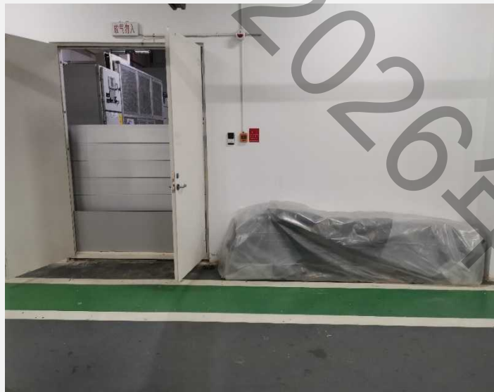
郑州阜外华中医院——地下车库档水板插槽、配电间叠梁闸板、应急队伍组成情况
