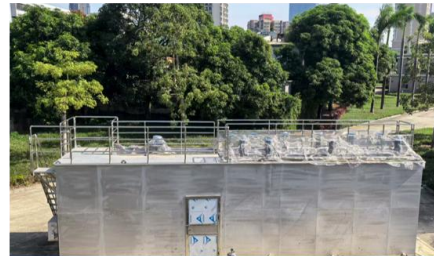
拱北水质净化厂AOA中试
